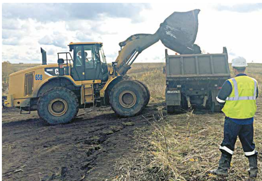
Экологи АО ХК «СДС-Уголь» совместно со специалистами Кузбасского ботанического сада разработали технологию, по которой недавно снятый слой земли сразу же переносили на рекультивируемый участок
