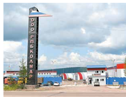
Ремонтно-производственная база «Колмар», 2019 г.
